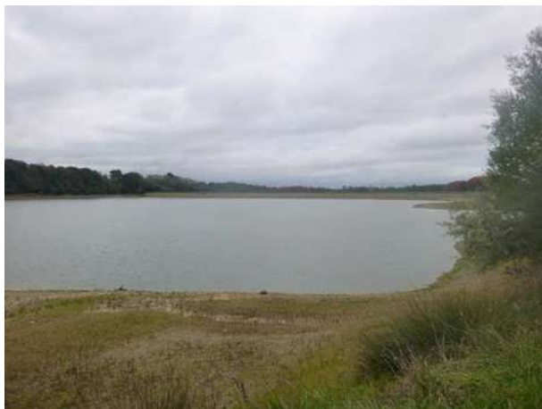
Retenue collinaire du Gioulé
