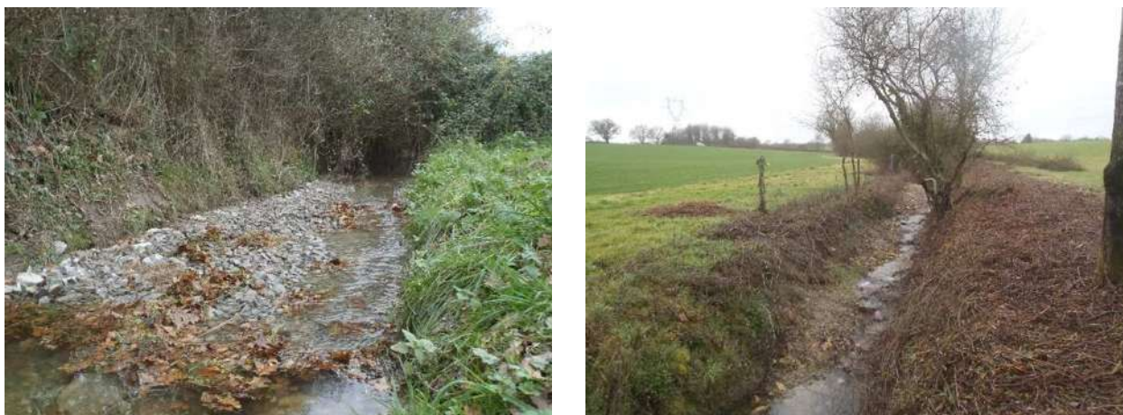
Exemple de recharge en dôme menée sur des cours d'eau du bassin versant de l'Isac (44)
