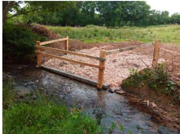
Descente aménagée clôturée (Source SIAD)
