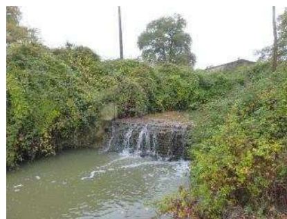
Déversoir sur le ruisseau du Gioulé
