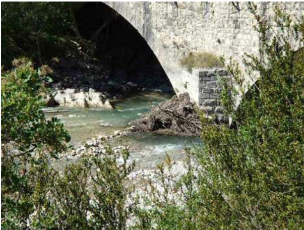
Exemple de gestion des embâcles menaçant la stabilité des ouvrages (Source SIVU du Verdon))
