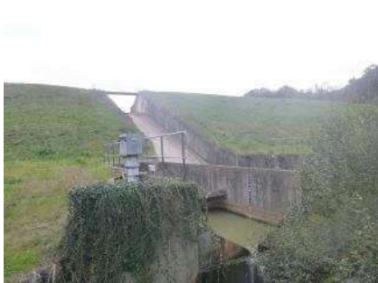
Retenue Collinaire sur le Gioulé
