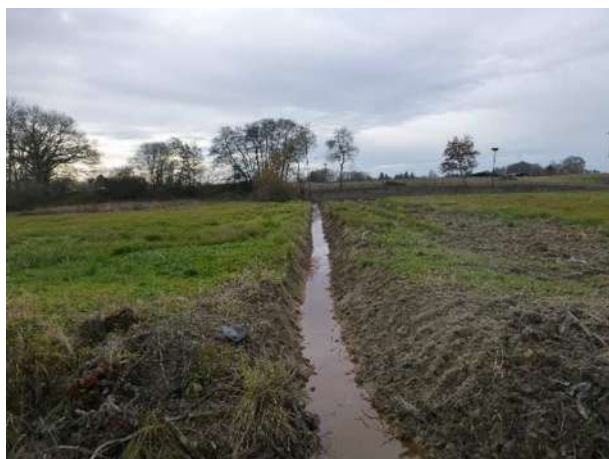
Fossé de drainage sur l'Estey à Yzosse
