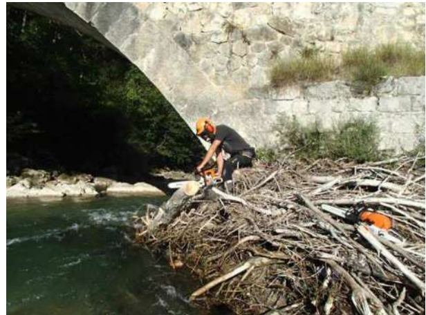
Exemple de gestion des embâcles menaçant la stabilité des ouvrages (Source SIVU du Verdon))
