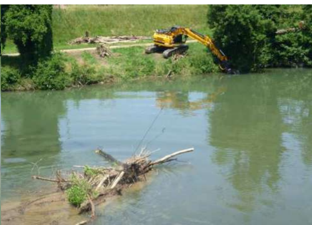
Retrait d'embâcles sur l'Adour, à proximité d'un pont
