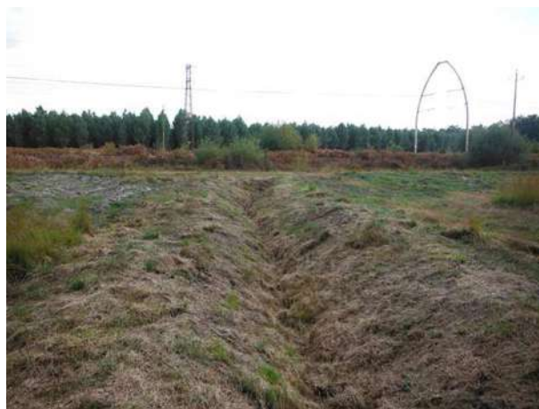
Fossé de drainage sur le Greffier à Lesgor
