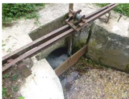
Vannes levantes sur le ruisseau de l'Ouzenté
