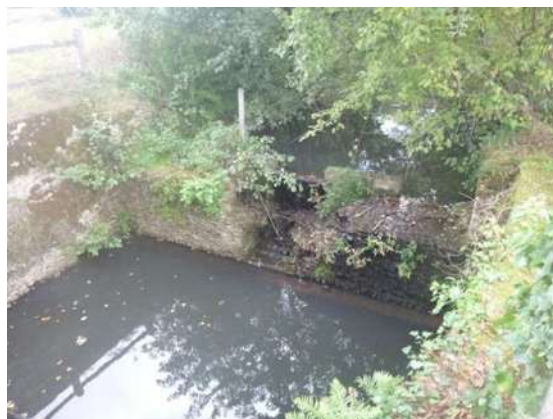
Seuil en rivière sur le ruisseau du Courdaoute
