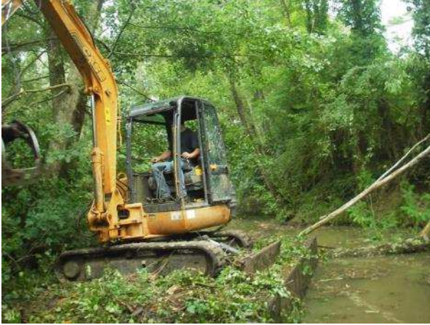
Travaux de restauration de la ripisylve effectués en berge (source SMAVLot)
