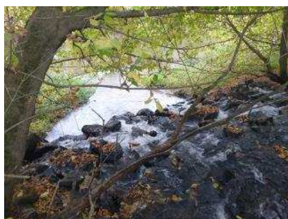
Enrochements sur le ruisseau du Martinet
